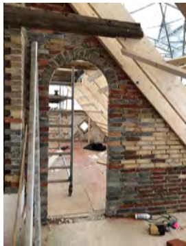
Genbrugstegl og tømmer fra Hedekov og lokale byggepladser Kalkbeton sidefundament
