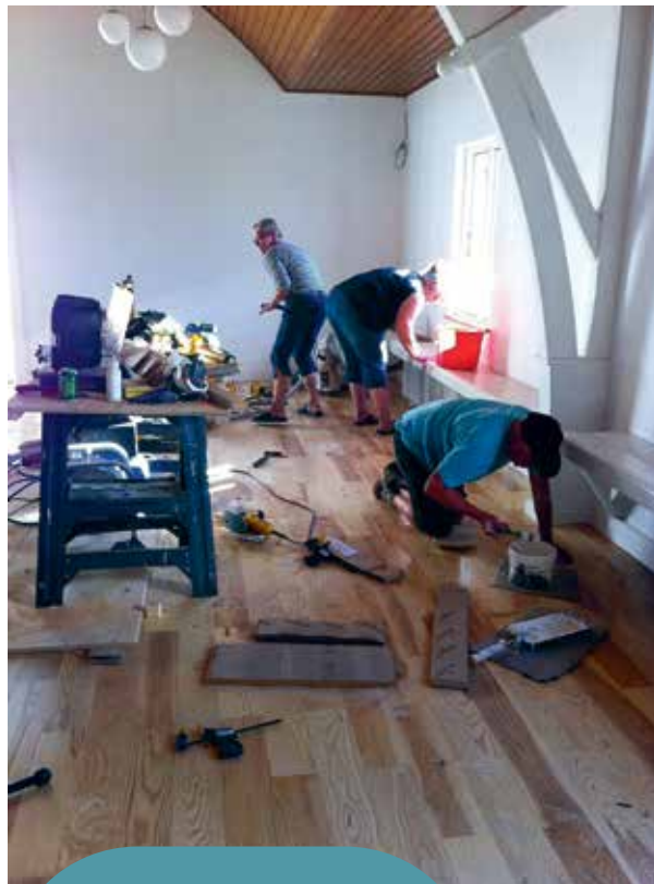
Nyt gulv, nyt tag, isolering af vægge og en tidssvarende indretning. Hellested Forsamlingshus har fået en fysisk opgradering.
