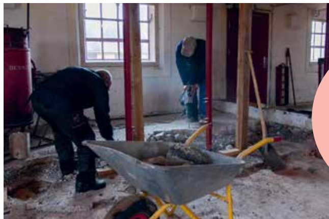
Den oprindelige belægning i stalden ser igen dagens lys.
