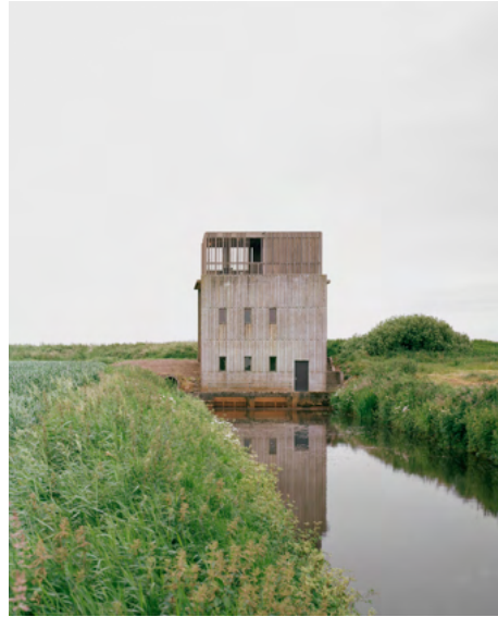
Pumpestation Øst. Fotos: Rasmus Norlander.
