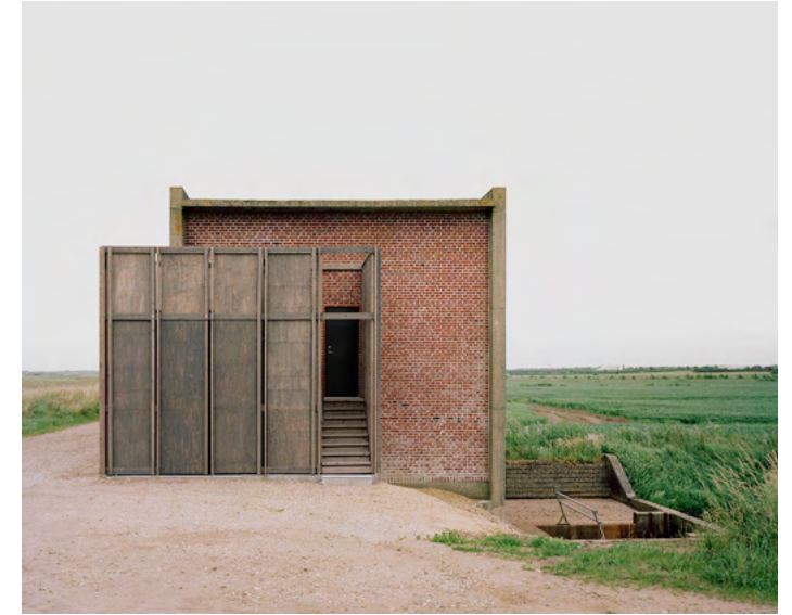
Pumpestation Syd, eksteriør. Fotos: Rasmus Norlander.
