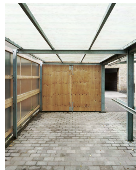
Ny facilitetsbygning, eksterior
