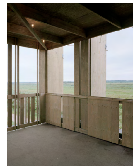
Pumpestation Øst. Fotos: Rasmus Norlander.
