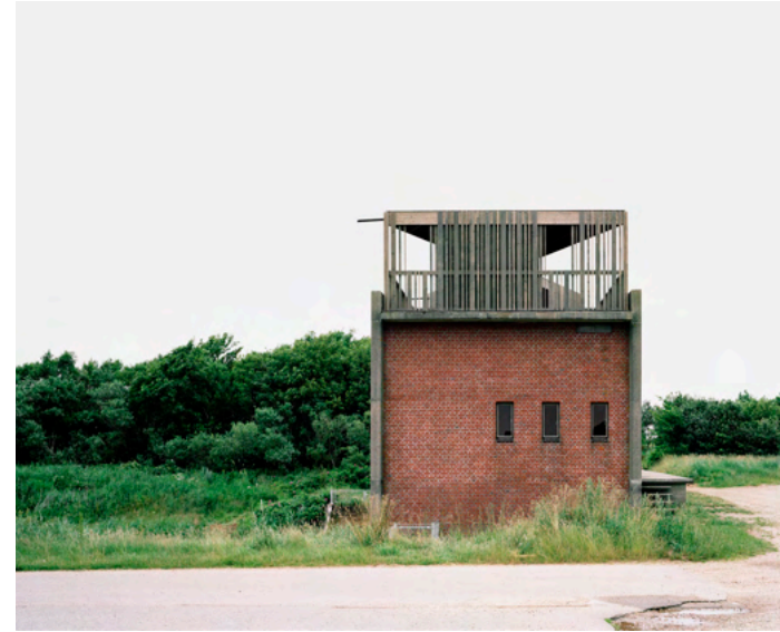
Pumpestation Nord, eksteriør. Fotos: Rasmus Norlander.
