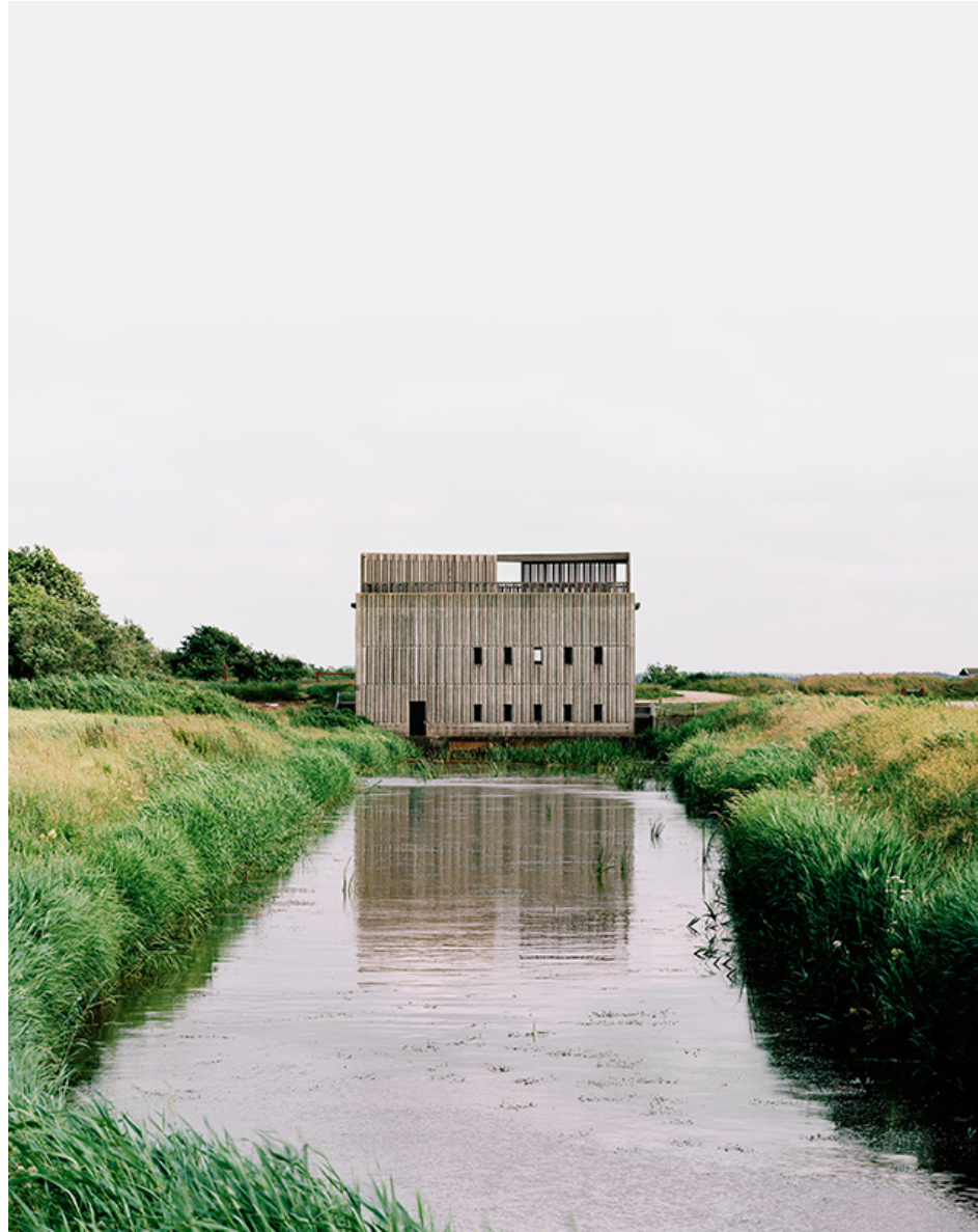
Tilbygningen på den eksisterende pumpestation fortolker betonrelieffet i en ny træstruktur, som beklædning og konstruktion.
