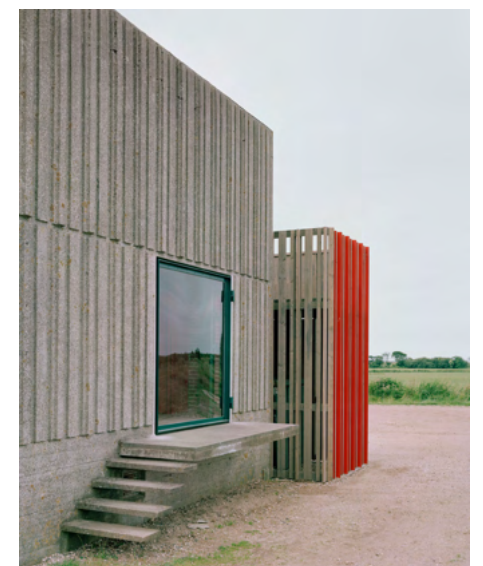
Pumpestation Øst. Fotos: Rasmus Norlander.
