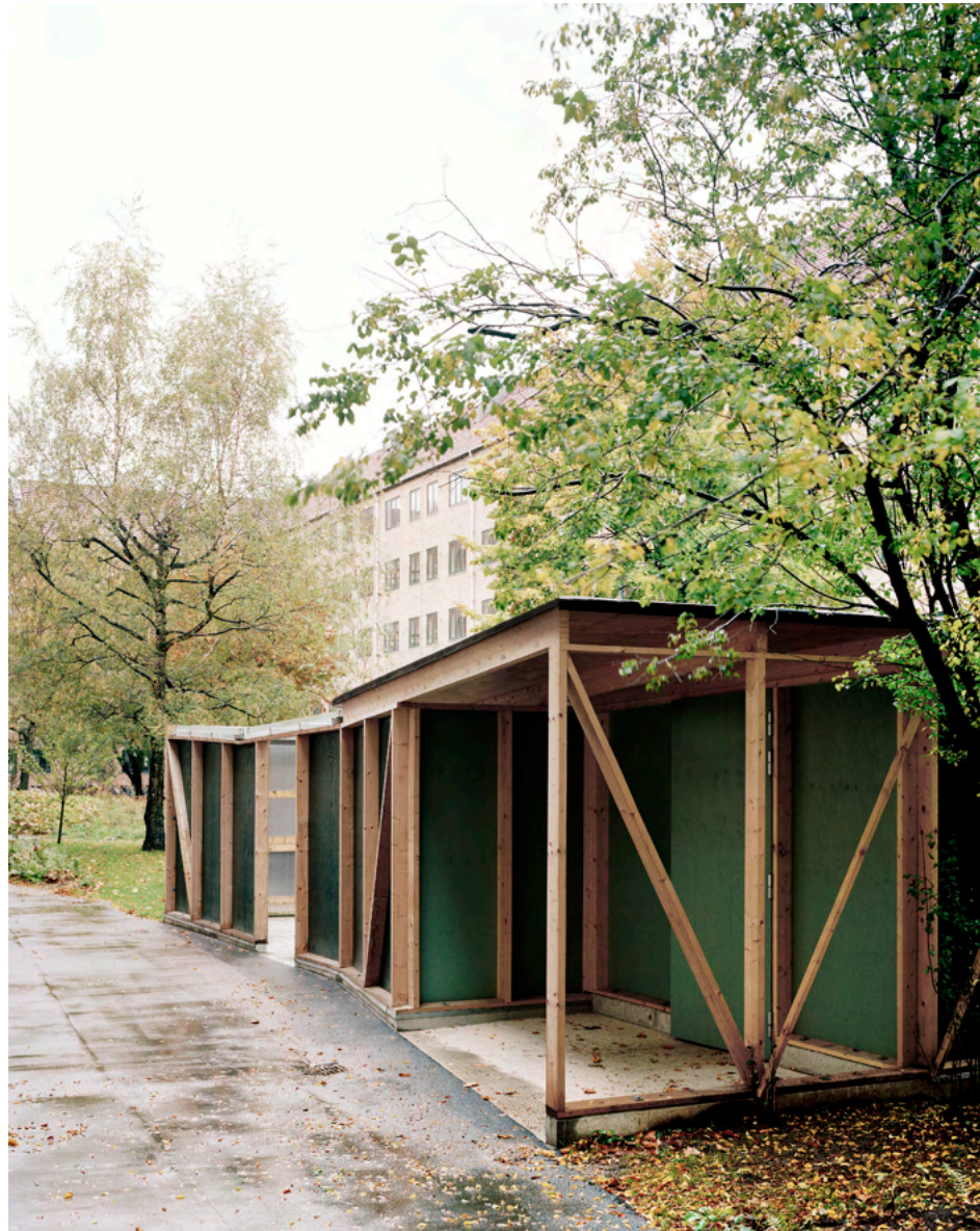
Ny facilitetsbygning, beklædningen placeret på træskelletkonstruktionens inderside skaber rytme og lethed i samspil med få espalierlister.
