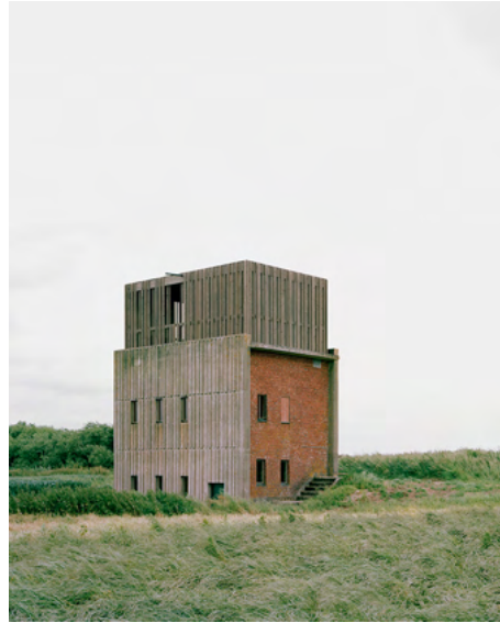
Pumpestation Øst. Fotos: Rasmus Norlander.
