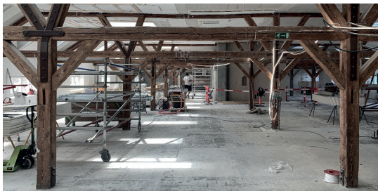
Forhold før og under transformation
