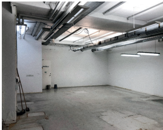
Forhold før transformation
