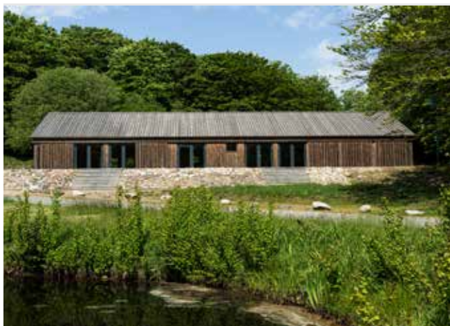
For at skabe en naturligt forbindelse mellem inde og ude kan de store vinduespartier i laden åbnes op, så naturen kan komme indenfor.
