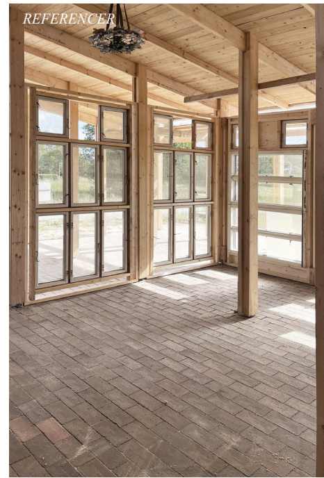
Vinduesporte af genbrugte vinduer
