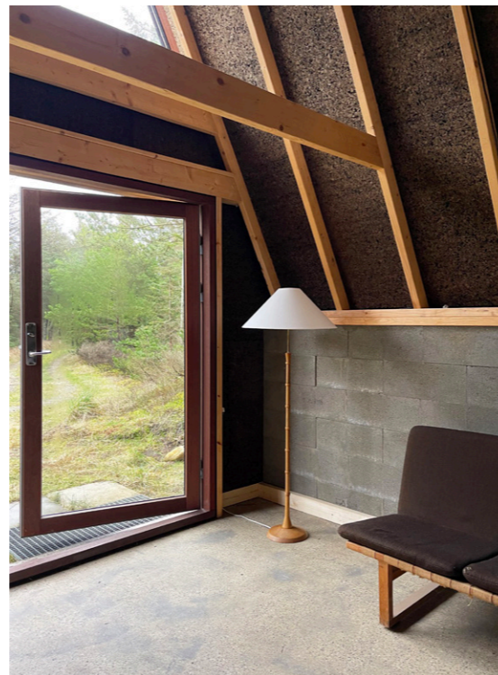
I hytten er konstruktionen og korkisoleringen synlig
