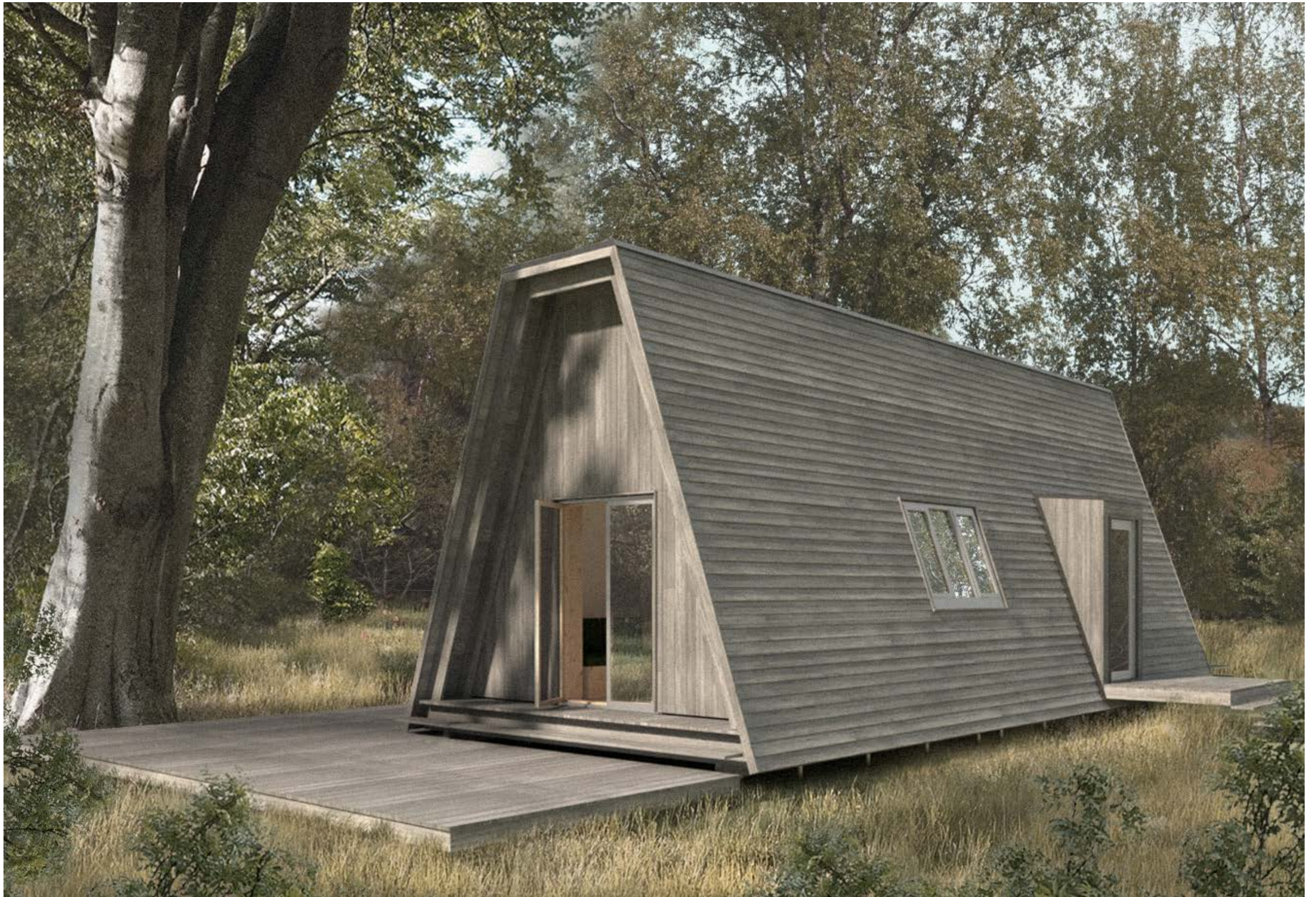
Tinyhouse Samarbejde med Mette Lange Architects og Tømrer Mester Christian Rejnholdt
